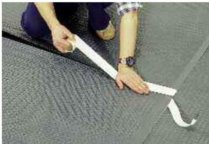
12. I tvärskarvar läggs våderna med kanterna mot varandra. Skarven förseglas med det 50 mm breda skarvbandet. Ytorna ska vara torra samt fria från fett och damm. OBS - skyddspappret skall inte tas bort på ovasidan. Tryck till så att det blir ordentligt tätt.
