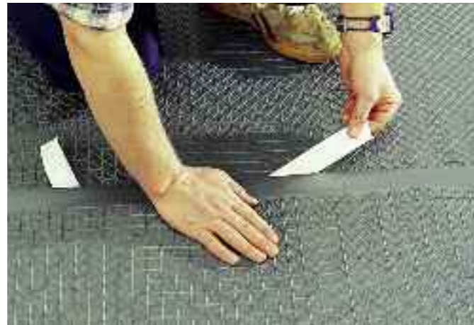
11. Ta bort skyddspappret. Börja mitt i skarven och arbeta ut mot dess ändrar. Tryck samtidigt fast skarven för att få ordentligt tätt.
