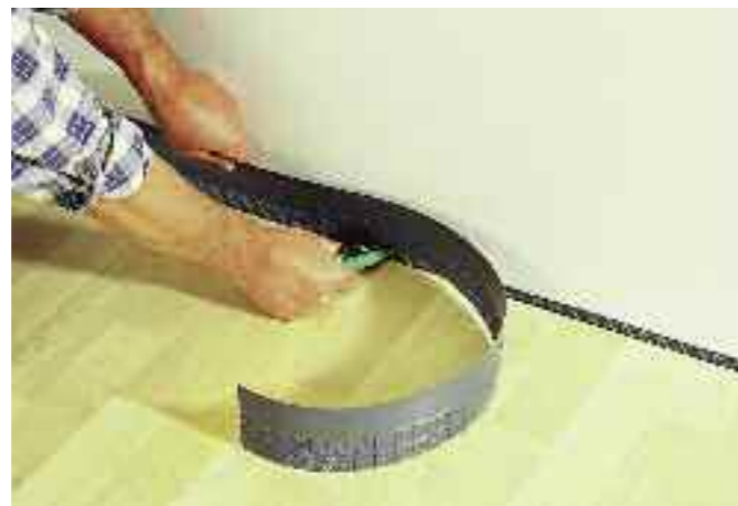
15. I de fall man har uppvik mot vägg skärs överskottet bort när golvet är färdiglagt. Renskar Fonda Special ca 10 mm ovanför färdigt golv. För väggar med uppvik används en sockellist.
