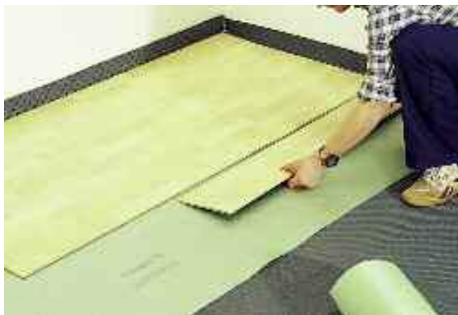
14. När Fonda Special har lagts färdigt monteras, beroende på övergolvskonstruktionen, stegljudsdämpare och/eller mellanskikt innan yttskiktet appliceras. Stegljudsdämparen hjälper även till att ta upp mindre ojämnheter i underlaget. För att minimera höjdskillnader vid skarvar i Fonda Special, kan stegljudsdämparen skäras bort vid dessa skarvar.
