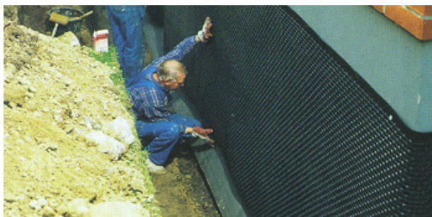
Bild 4. Utrullning av FONDA Universal.
