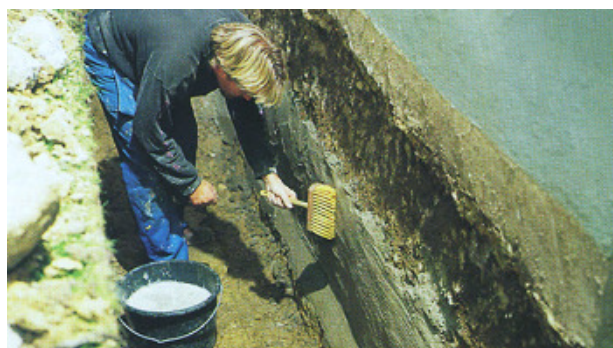
Bild 2. Slamning av väggyta
