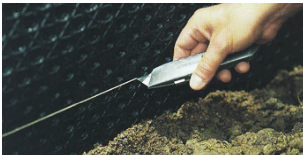
Bild 6. FONDA Universal skärs av ca 10 cm under avsedd marknivå .
