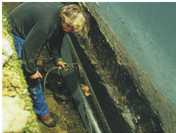
Bild 3. Membrane 3 svetsas på källarväggen.
